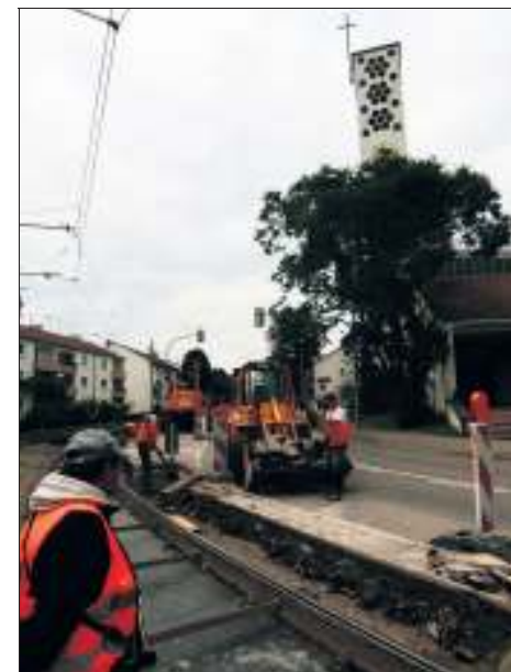
Die Bauarbeiter müssen an der Gleisüberfahrt in Rot größere Schäden reparieren, als gedacht.
